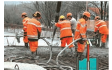
Типичный пример использования вибрации в других отраслях: трамбовка бетона.
