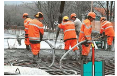
Ejemplo típico de la utilización de la vibración en otros ramos: p. ej. la vibración del hormigón
